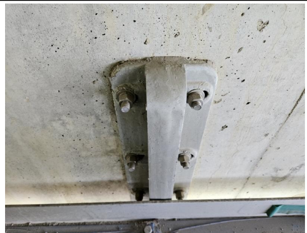
점검통로 고정장치 상태양호 P3
