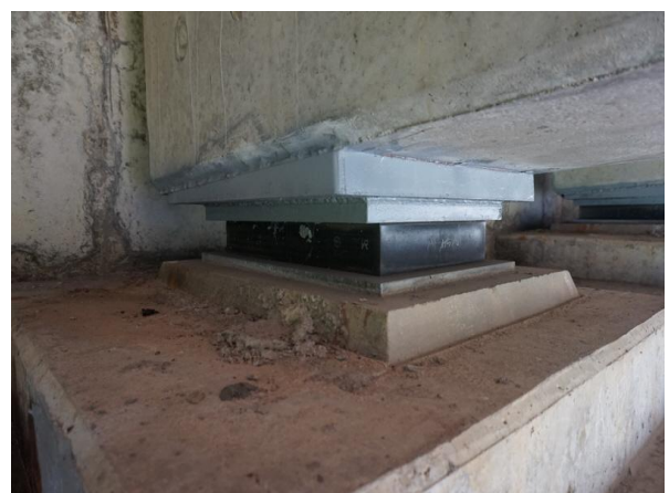
받침장치 보수 상태양호 A1 SH5
