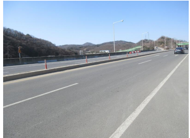
교면포장 상태양호 S2
