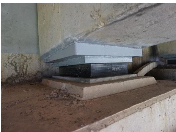
받침장치 보수 상태양호 A1 SH4
