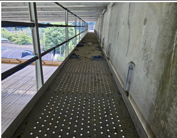
점검통로 상태양호 P3
